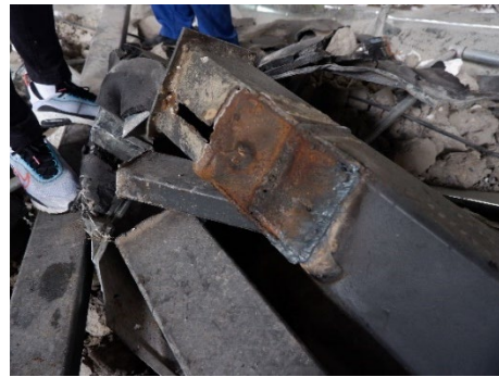
图 9 钢桁架 5-B 轴节点位置弦杆破坏形态
