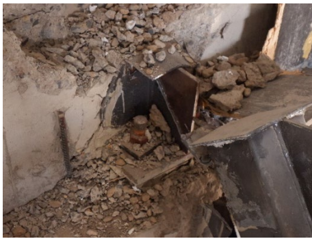
图 8 钢桁架 3-B 轴节点位置破坏形态
